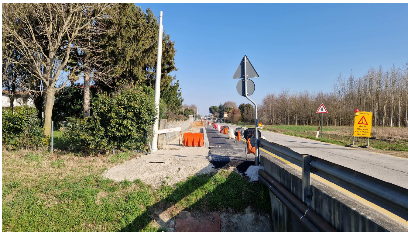
S.P. 34 – fine pista ciclabile in corso di realizzazione comune di Borgoricco
