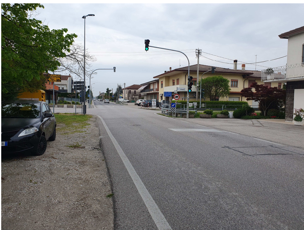
S.P. 34 – incrocio tra via Bassa III e via Longni – inizio ambito intervento
