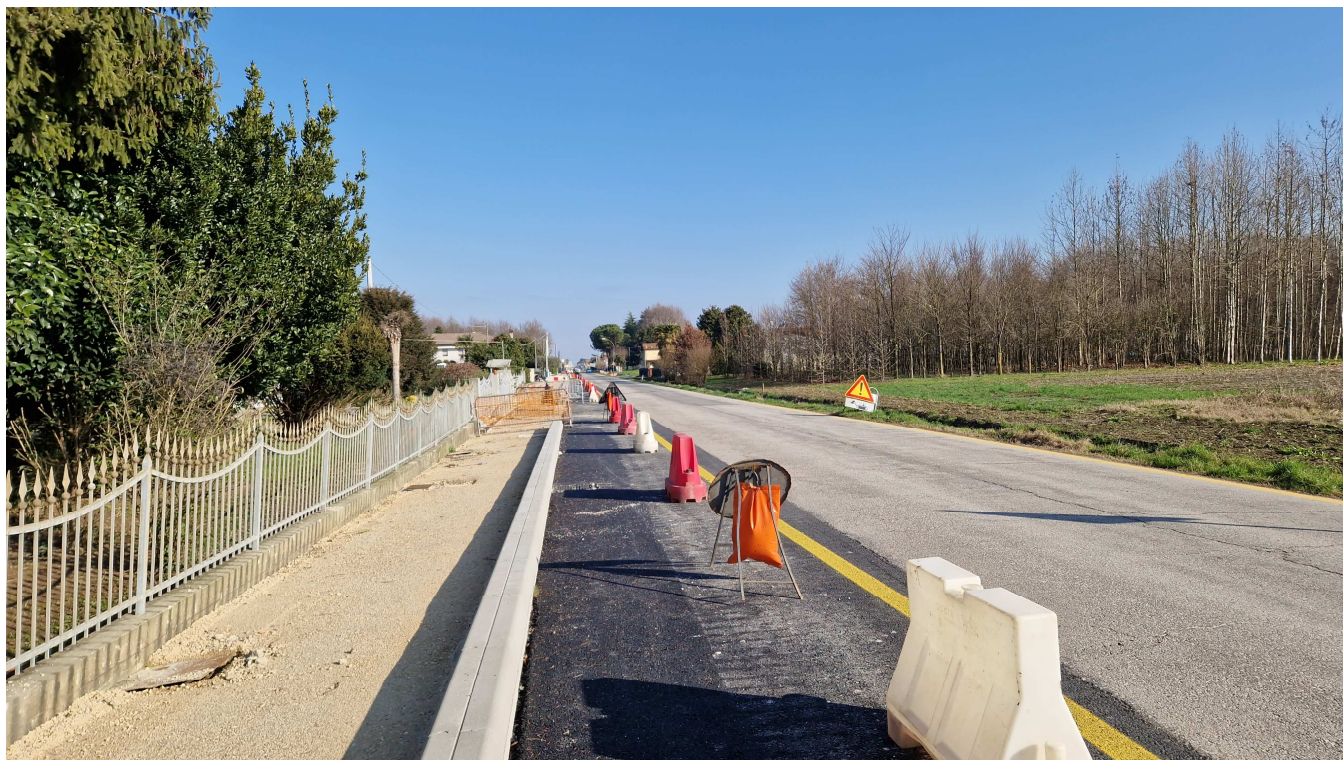
Pista ciclabile in corso di realizzazione comune di Borgoricco
