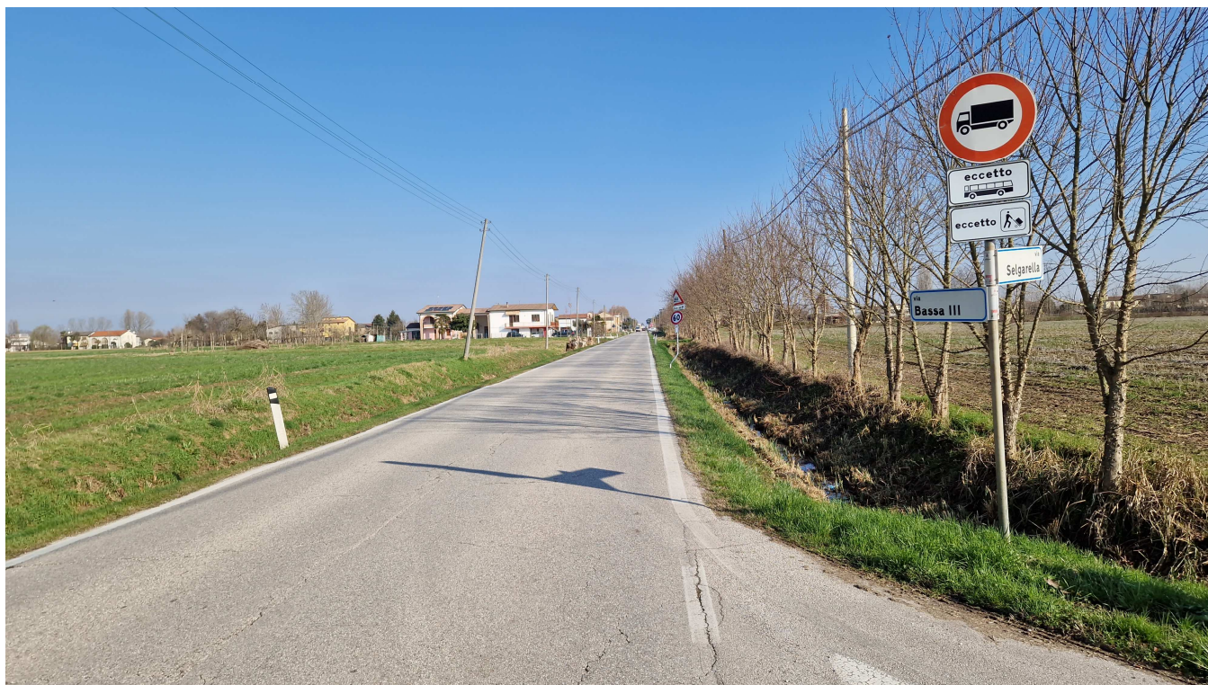
S.P. 34 – incrocio tra via Bassa III in prossimità incrocio con via Selgarella
