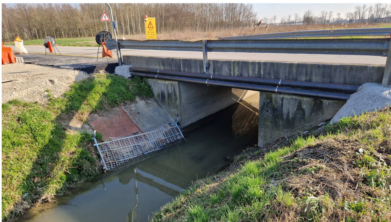
S.P. 34 – attraversamento Canale Lusore
